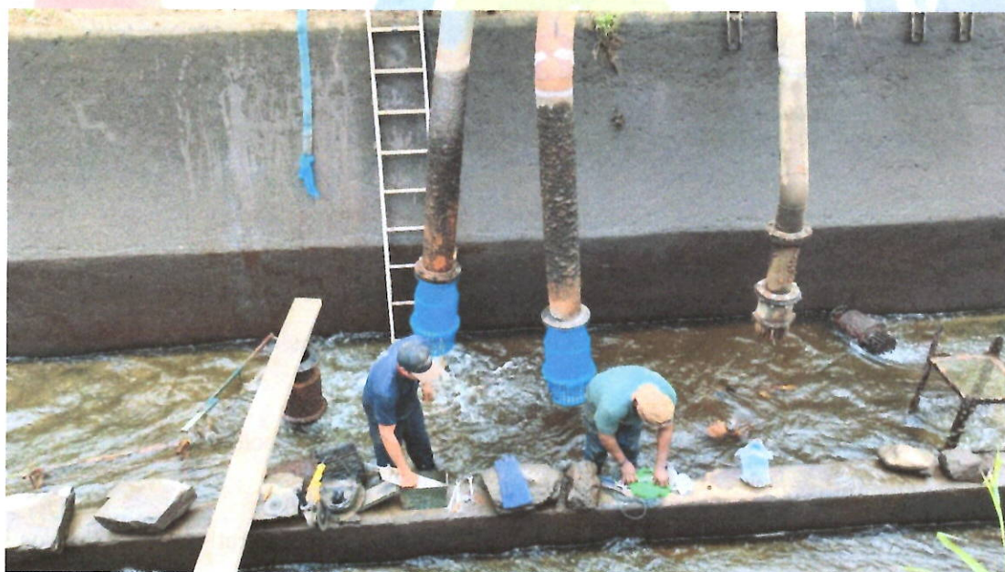
Ilustración 6. Limpieza y Mantenimiento Preventivo en Captación en la Ciudad de Arenillas.
