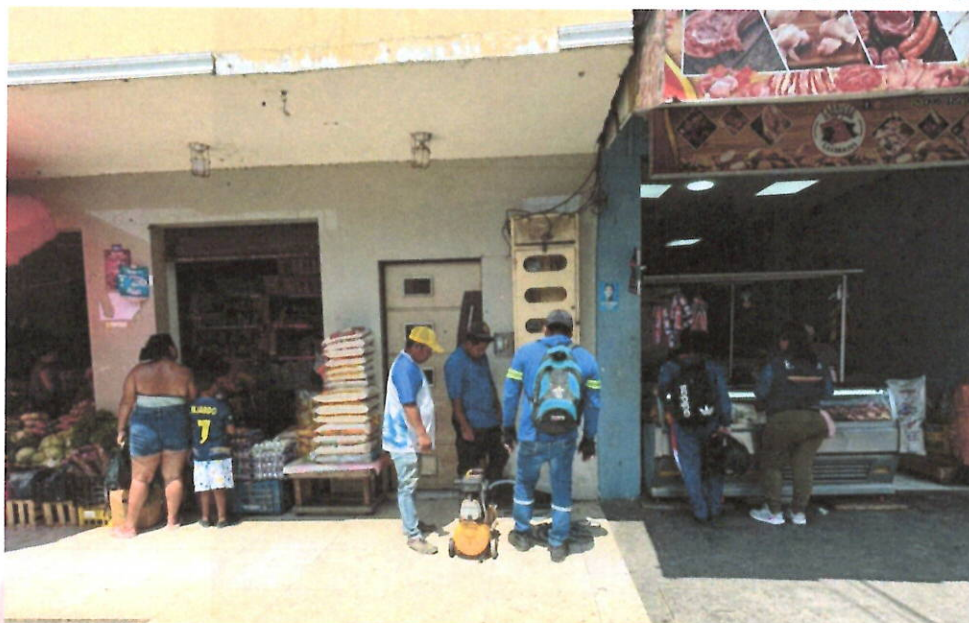
Ilustración 10. Mantenimiento y Reparación de Acometidas Domiciliarias en la Ciudad de Huaquillas.
