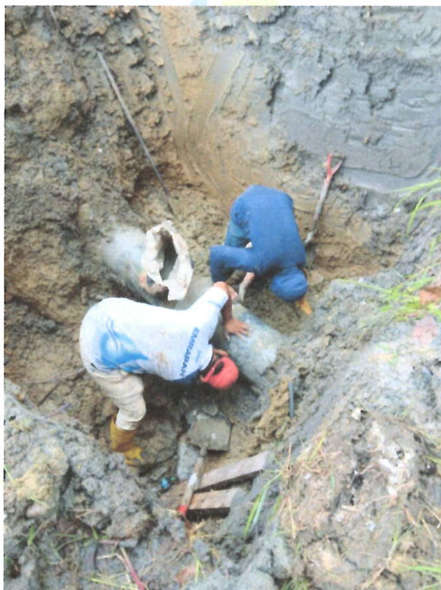
Ilustración 8. Reparación de una fisura en la tubería principal del pozo PH3, PH4 y PH6 ubicado en el sector de Migración.
