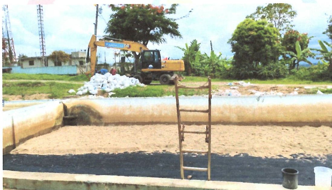
Ilustración 5. Limpieza y Mantenimiento Preventivo en Planta Loma Quito en la Ciudad de Arenillas. (Lavado de floculadores, sedimentadores y filtros)
