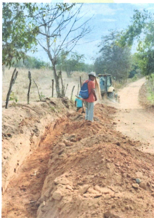
Ilustración 4. Instalación de redes nuevos catastro
