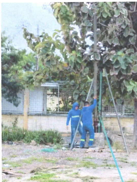
Ilustración 12. Mantenimiento correctivo del sistema de bombeo del pozo PH2, ubicado en el sector Ceibillo del cantón Huaquillas.
