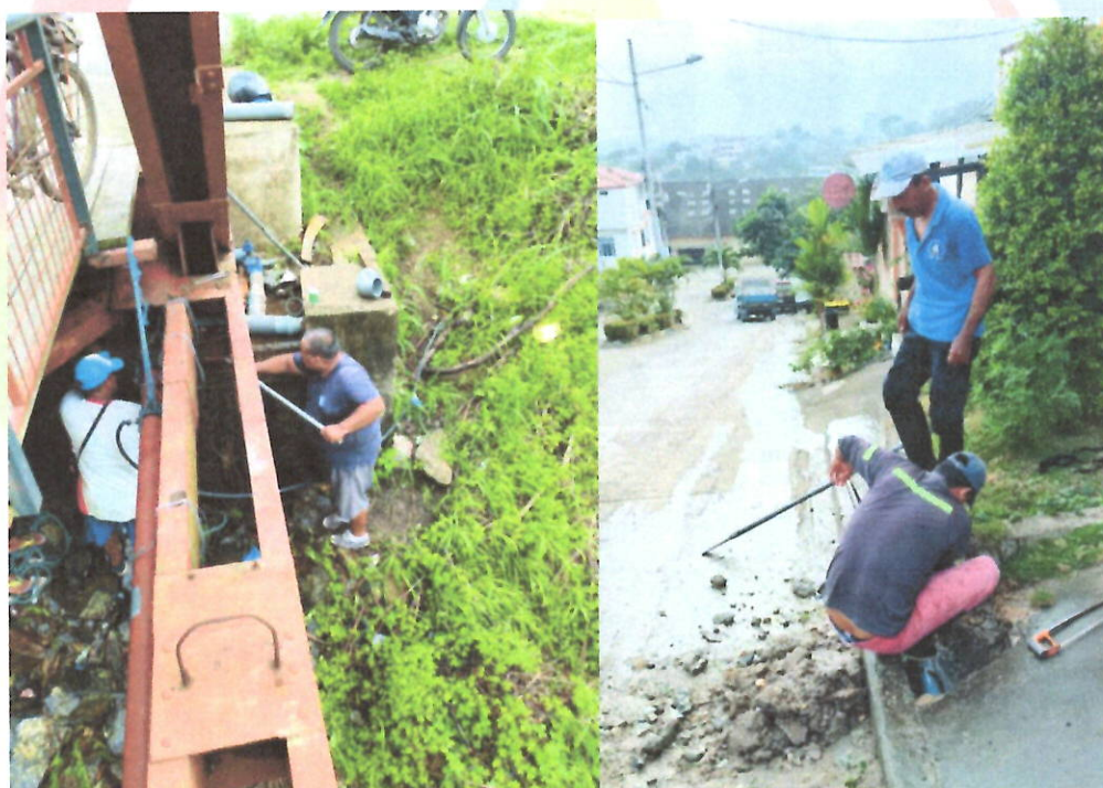
Ilustración 2. Atención de daños y fugas en tuberías en distintos sectores de los cantones Arenillas.
