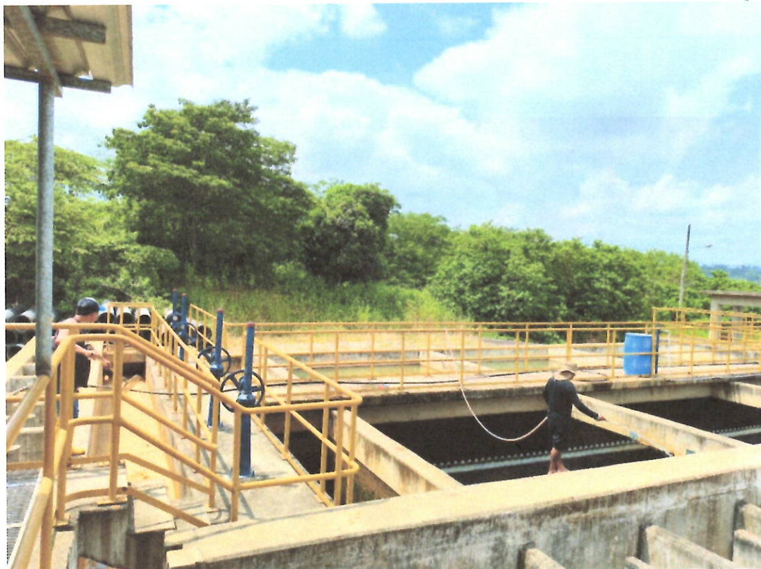
Ilustración 7. Limpieza y Mantenimiento Preventivo en Planta Regional en la Ciudad de Arenillas. (Lavado de floculadores, sedimentadores y filtros)
