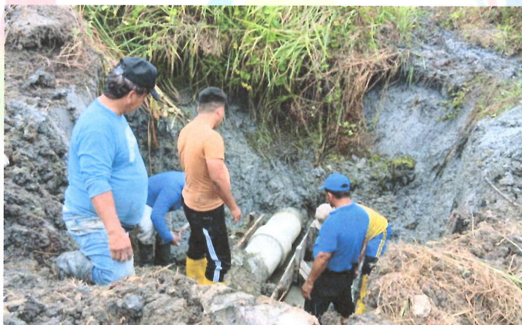
Ilustración 14. Mantenimiento y Reparación de Redes Primarias y Secundarias en la Ciudad de Huaquillas.
