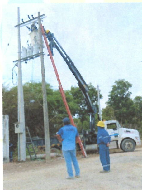
Ilustración 13. Coordinación con CNEL para el cambio de dos postes eléctricos ubicados en el área externa del pozo PH3 donde se ubica los transformadores, debido a su deterioro estructural.
