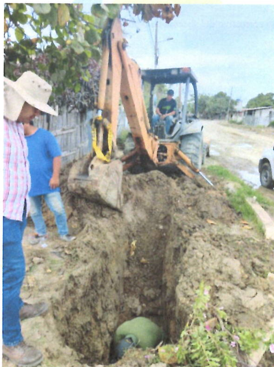
Ilustración 11. Mantenimiento y Reparación de Redes Primarias y Secundarias en la Ciudad de Huaquillas.
