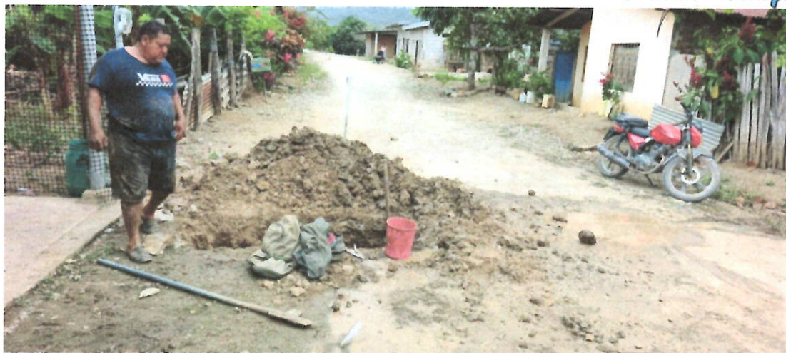
Ilustración 3. Mantenimiento y Reparación de Acometidas Domiciliarias en la Ciudad de Arenillas.
