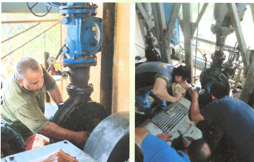
Ilustración 1. Cambio de turbina - Captación
